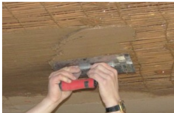
obr. 4 – nanášení směsi
