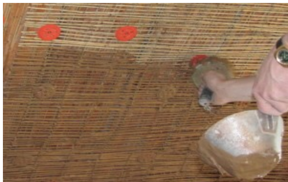
obr. 3 – nanášení přílnavostního nátěru
