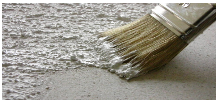
Nanášení kotvícího nátěru Gekkkosol.
